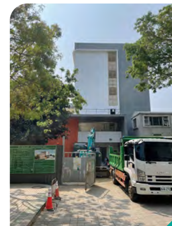
淑慎樓工地現況
